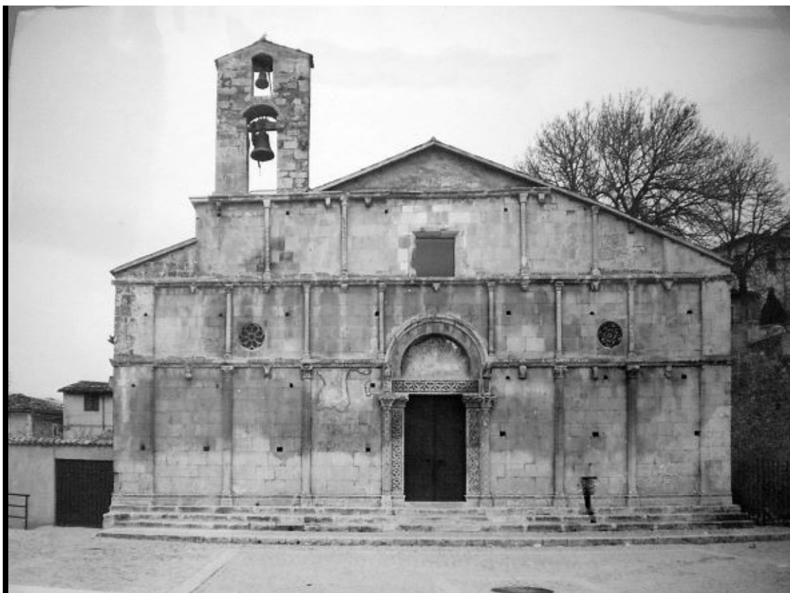
Fig. 1 Bazzano de L’Aquila (AQ), Chiesa di Santa Giusta, facciata
