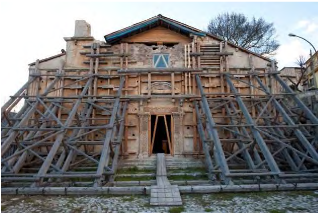
Fig. 8 Prata d'Ansidonia (AQ), Chiesa di San Paolo di Peltuinum, interno dopo il sisma Fig. 9 Bazzano de L'Aquila (AQ), Chiesa di Santa Giusta, facciata dopo il sisma
